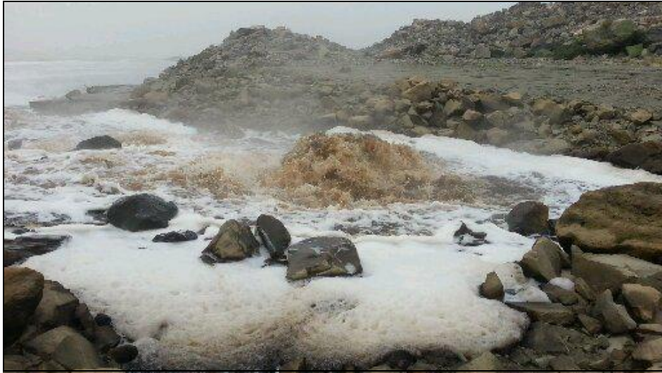
图 2-4 萧山临江污水处理厂排污口的污水正流入钱塘江
