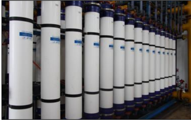
图 4-2 纺织印染废水处理超滤设备
